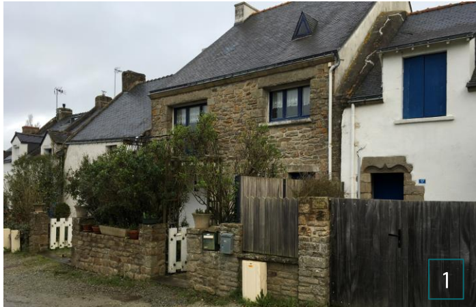
Noyau bâti caractérisé par un patrimoine architectural qui tend à être restauré
