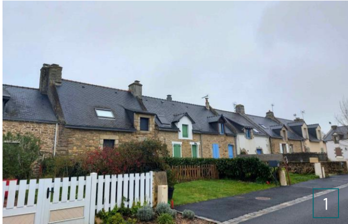
Alignement de bâti ancien à caractère patrimonial au centre du secteur
